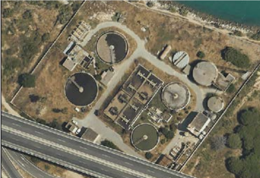
Figura 29. Vista aérea de la EDAR “El Trocadero” de Puerto Real. Fuente: Ortofotografía 2020-2021. 22
