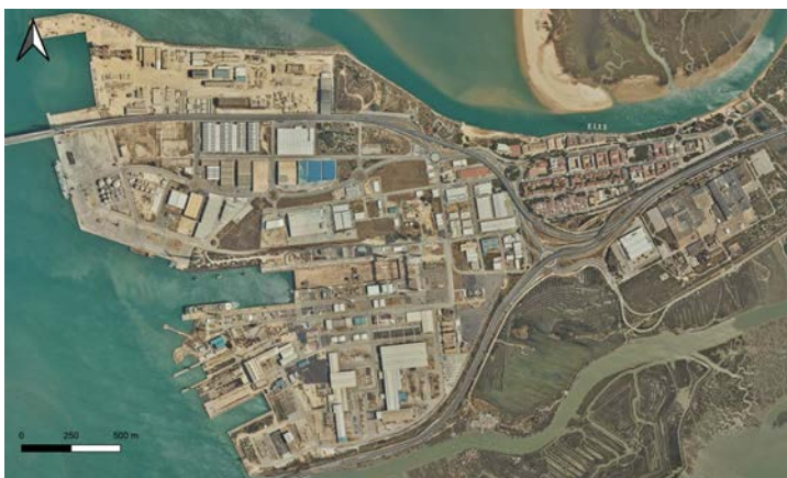
Figura 17. Vista aérea del polígono industrial de El Trocadero. Fuente: Ortofoto Digital de Andalucía año 2020 de la REDIAM.
