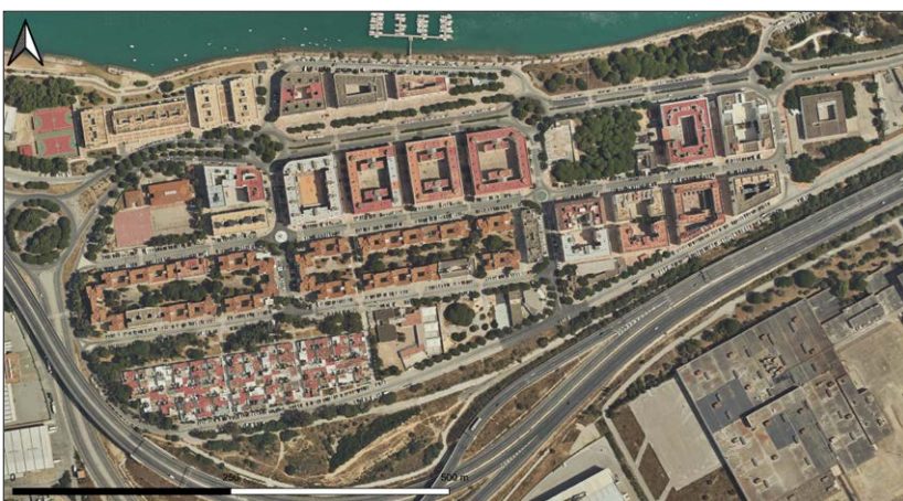
Figura 11. Vista aérea barriada Río San Pedro. Fuente: Ortofoto Digital de Andalucía año 2020 de la REDIAM.
