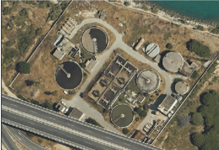
Figura 29. Vista aérea de la EDAR “El Trocadero” de Puerto Real. Fuente: Ortofotografía 2020-2021. 22
